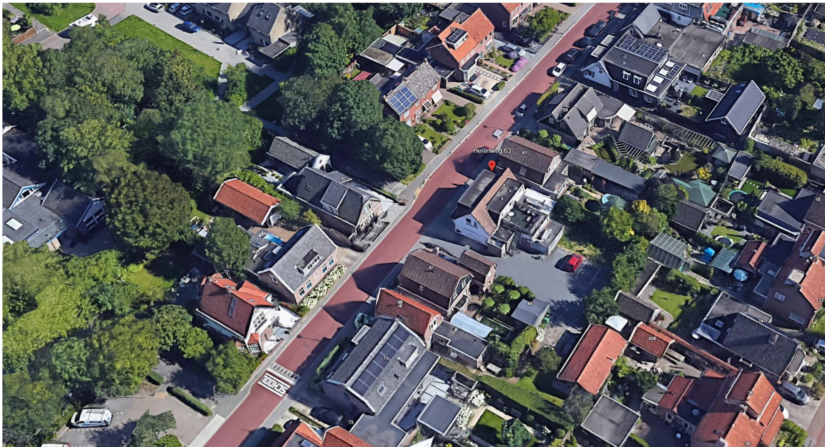
Huidige bebouwing, met achterliggend (parkeerterrein en PEN huisje)
