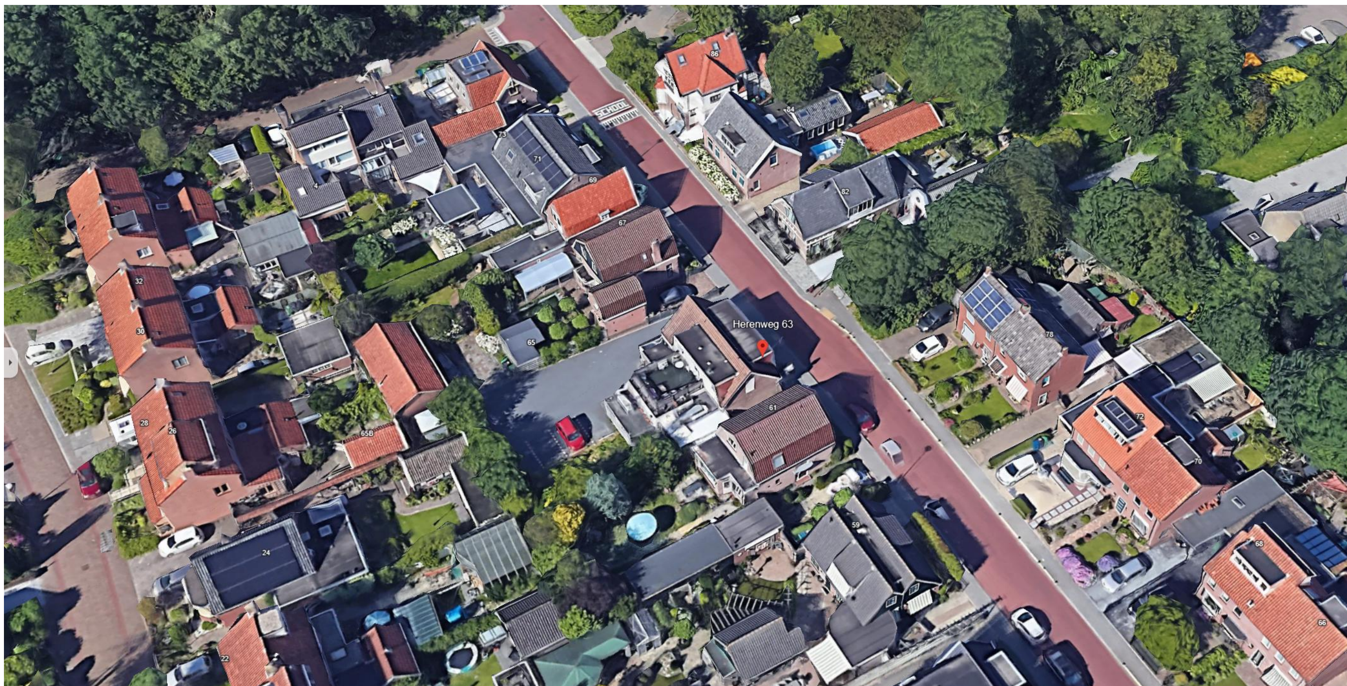
Bestaande bebouwing met inspringende gevellijnen, één en twee lagen met kap'
