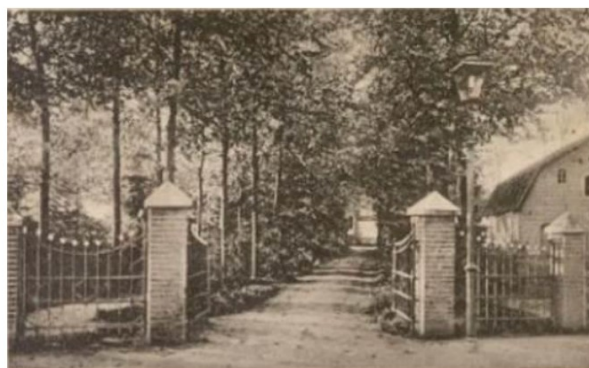
Afb. 2.28: Toegangsweg gemarkeerd door bakstenen poortpalen langs de Kerkstraat, z.j. Rechts het huis met de gebroken kap. (Herkomst: GIB, nr. 49856.)
