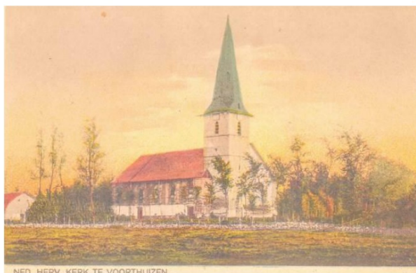
Afb. 2.21: Noordwestgevel van de kerk, links het (verdwenen) huis met de gebroken kap, z.j. (Herkomst: website Oud Voorthuizen, geraadpleegd februari 2020.)
