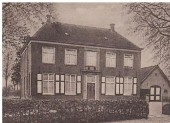
Afb. 2.17: Oude pastorie met naastgelegen schuur, gezien vanaf de Kerkstraat, z.j. [gedateerd door qopp.nl op 1920]. (Herkomst: qoop.nl.)
