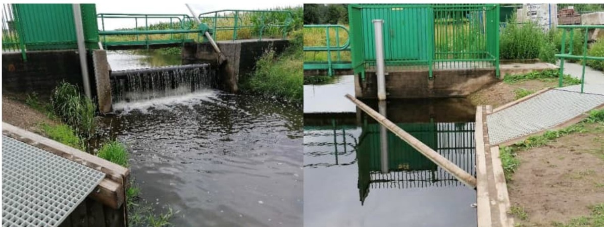
Figuur 97 Stuw Franken met de tijdelijke vispassage
