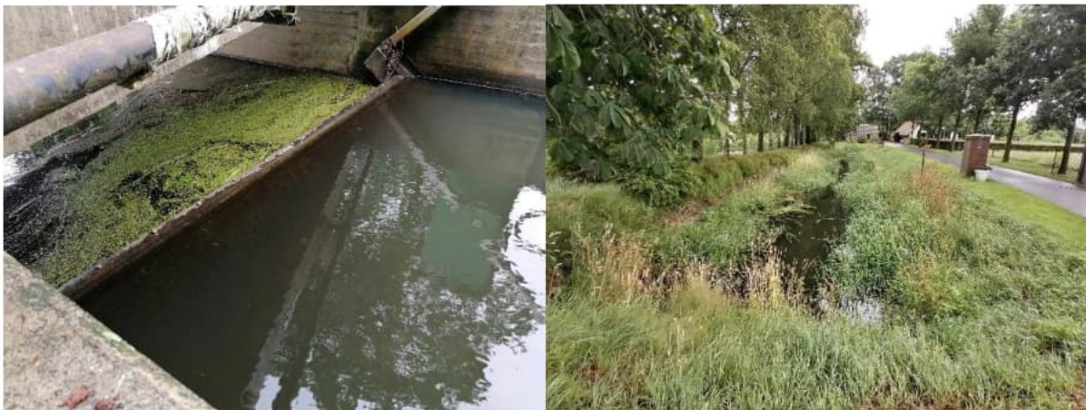
Figuur 96 Stuw en vispassage t.h.v. de Rulerweg ten oosten van het plangebied.
