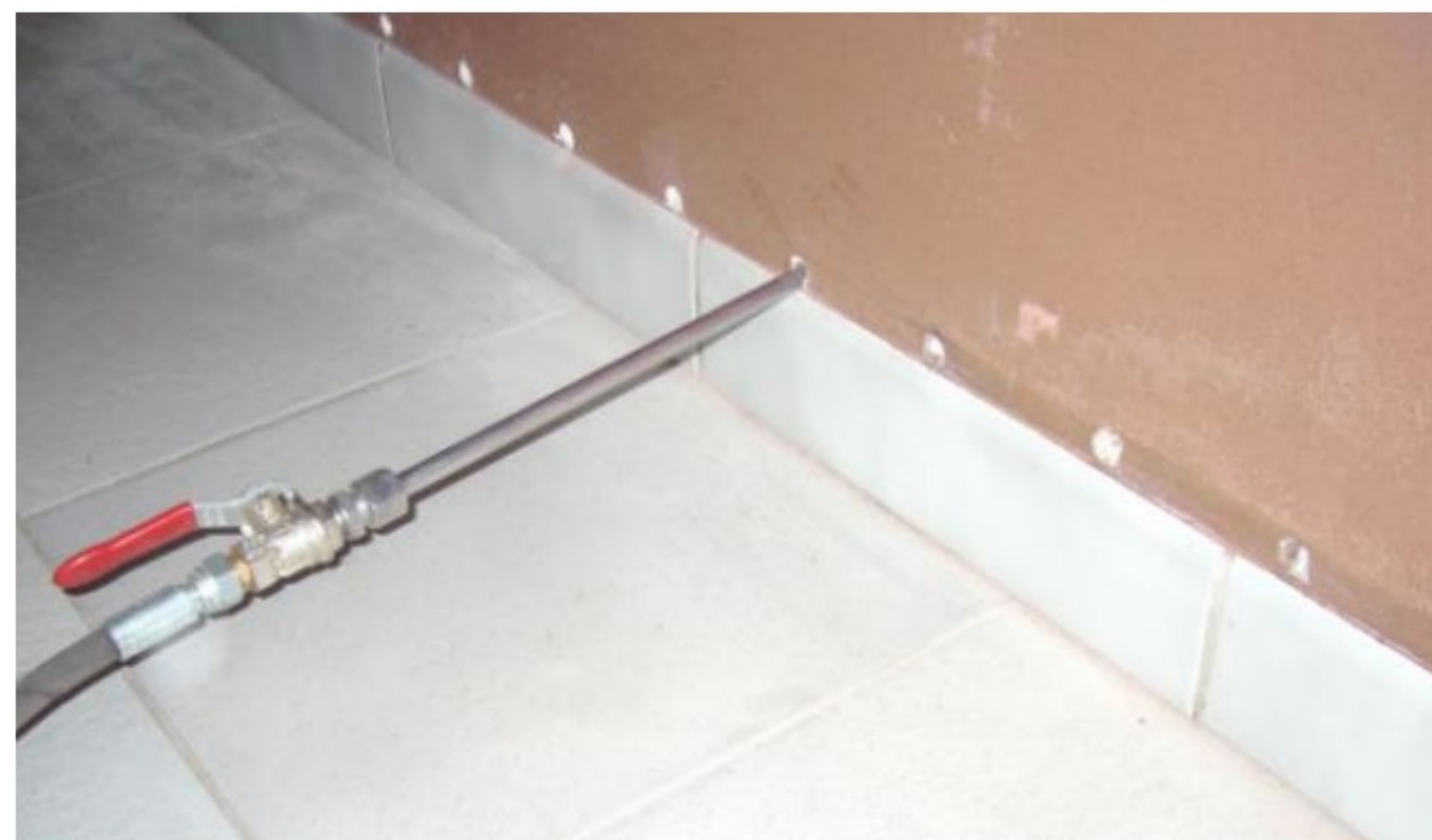
Injecteren waterafstotende vloeistof
