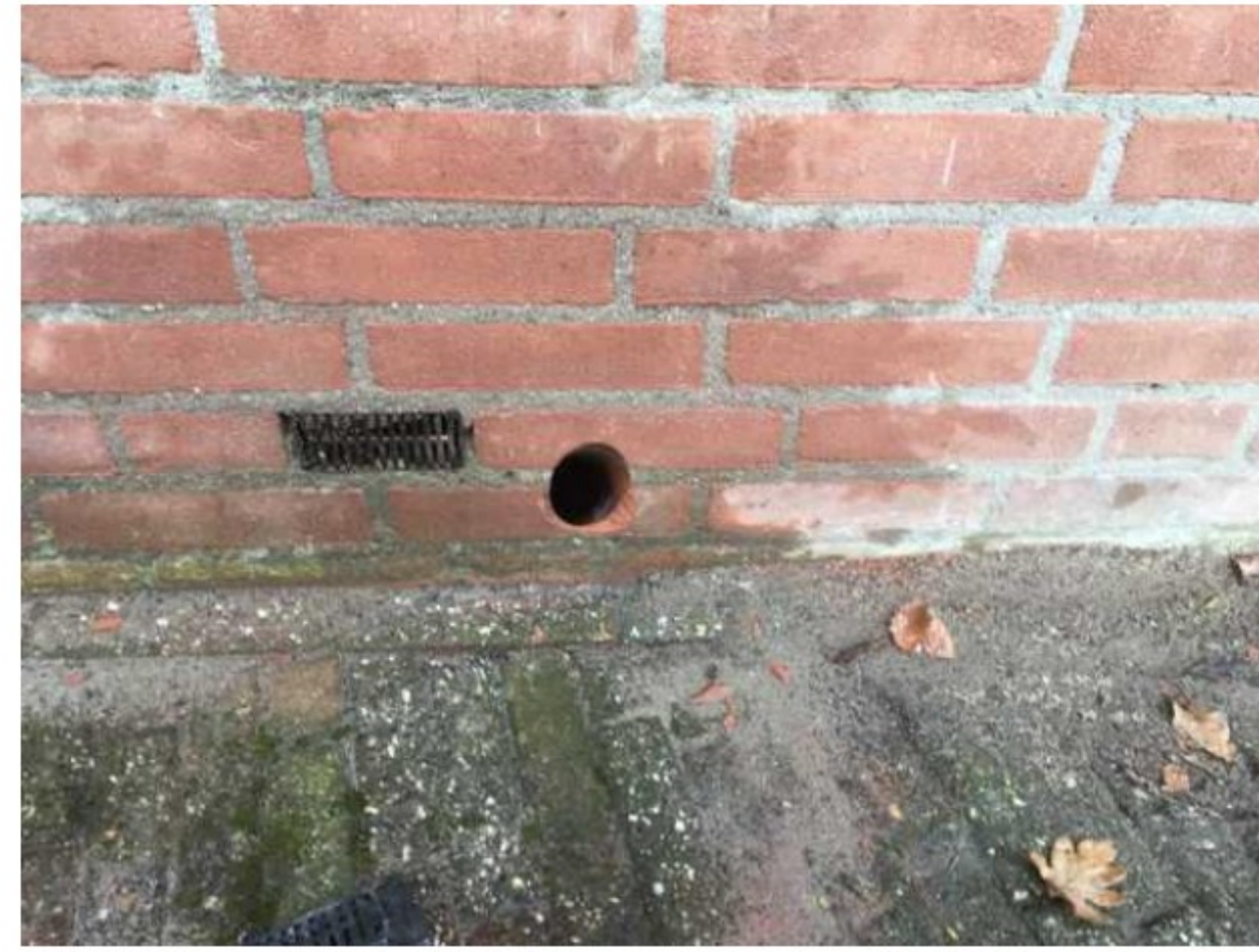
Ventilatieroosters kruipruimte
