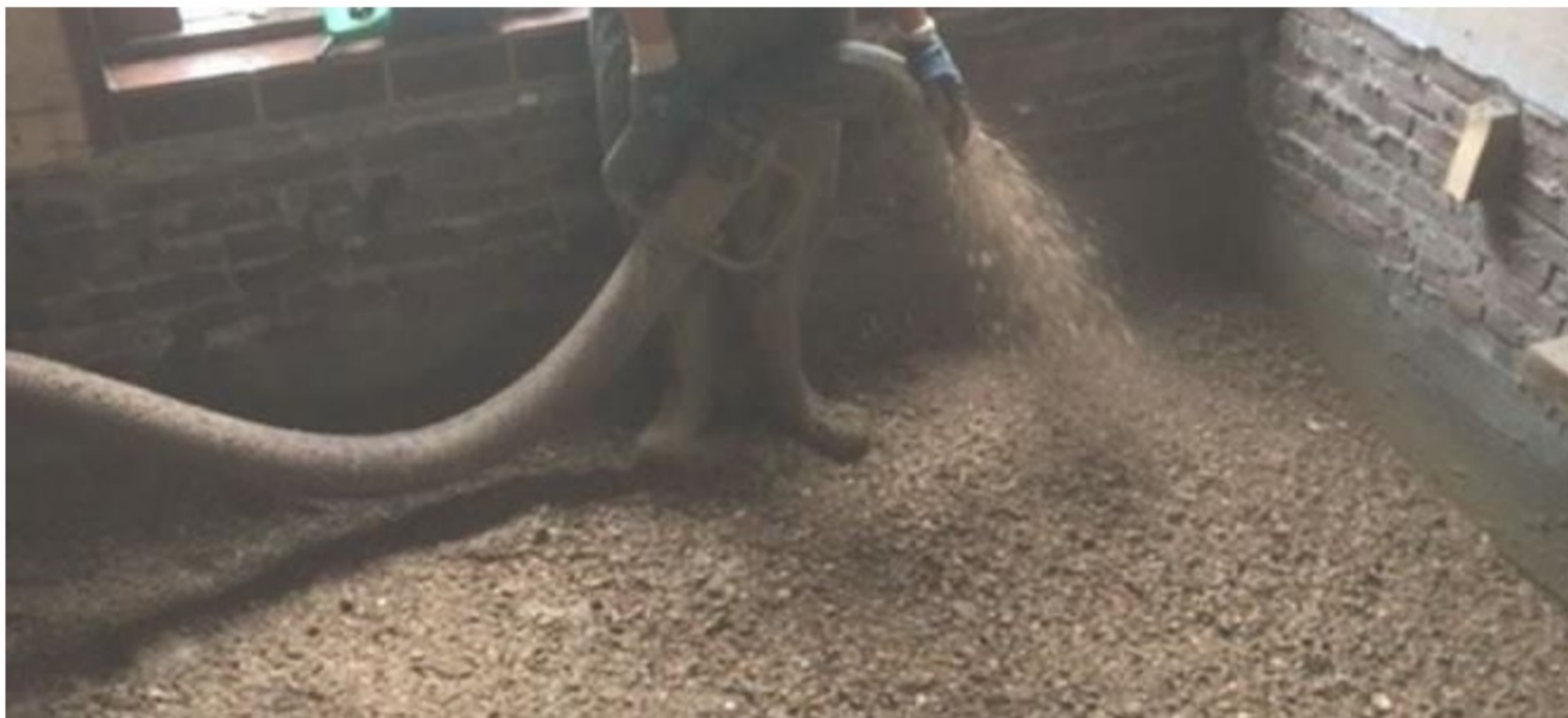
Zand blazen in kruipruimte
