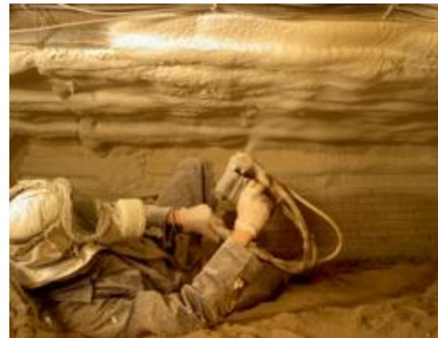
Dampdichte laag van polyurethaan
