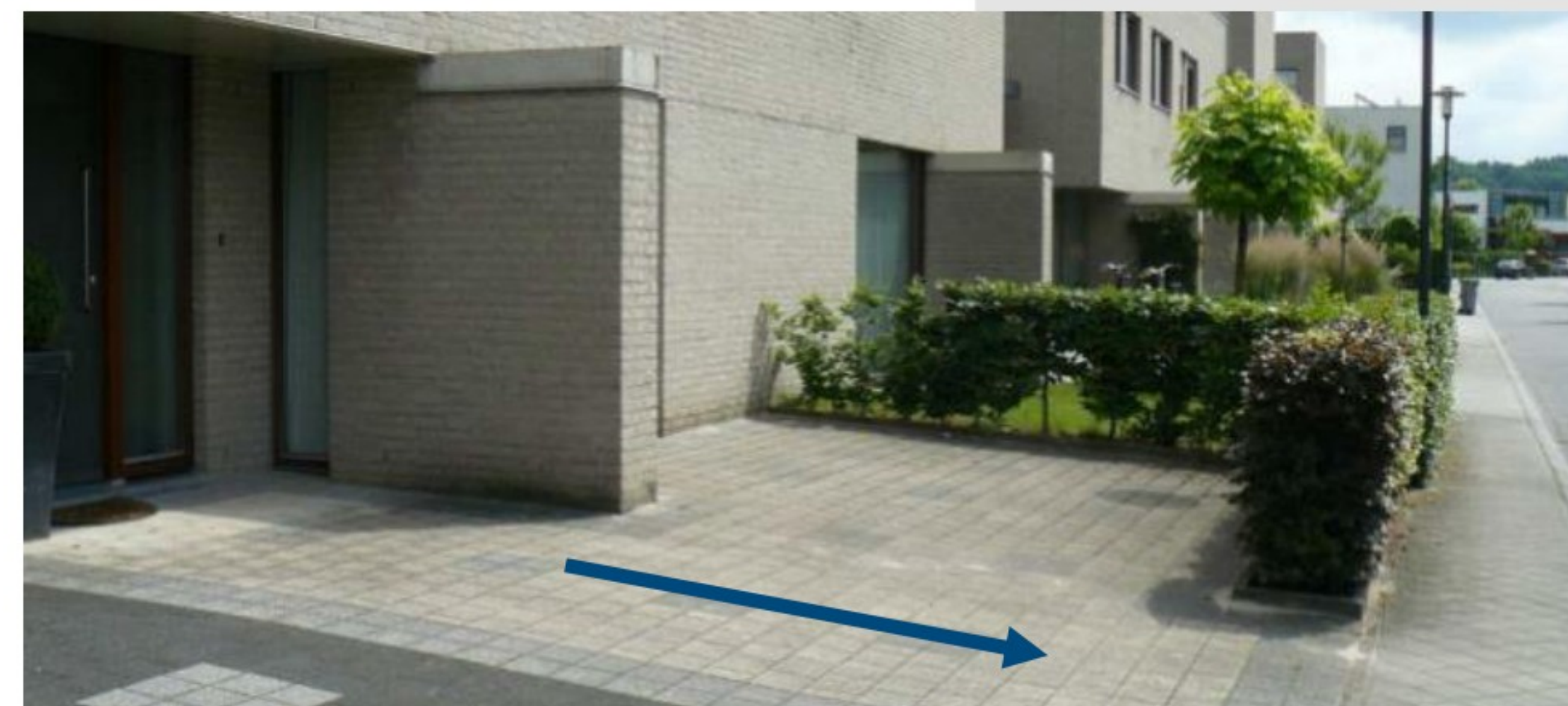
afstromingsrichting bestrating van woning af
