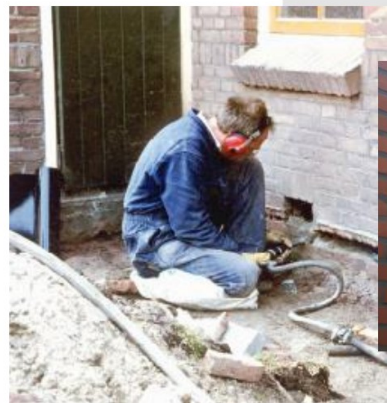
Aanbrengen loodslab buitenmuur
