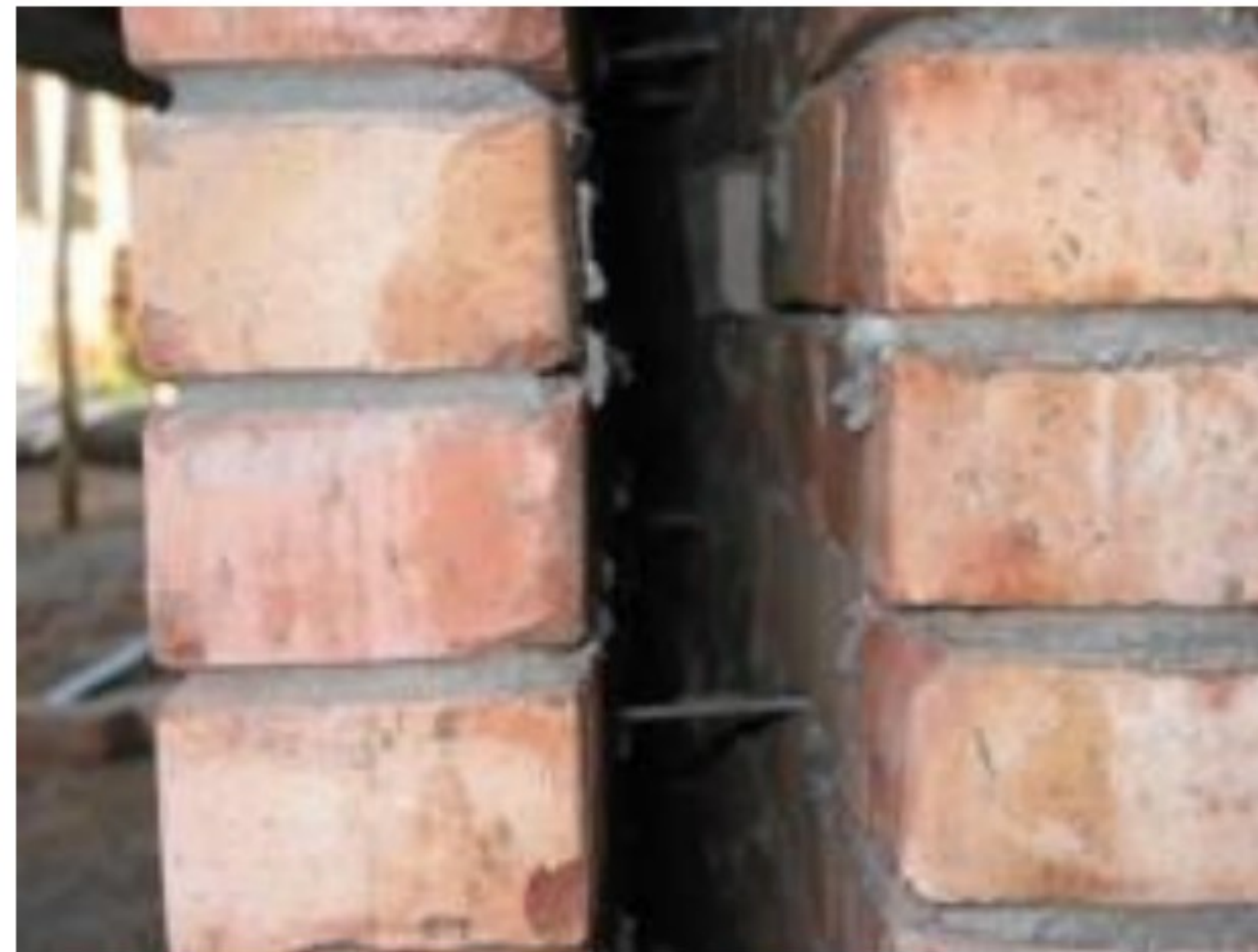
Spouwmuur controleren en schoonmaken
