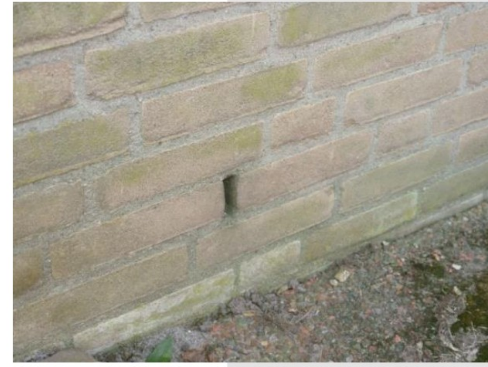
Open stootvoegen spouwmuur
