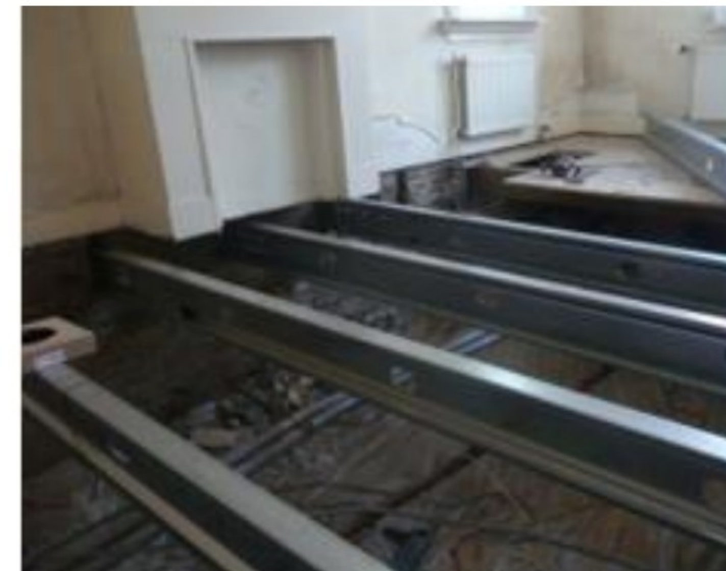
Vloer vervangen voor dampdichte constructie
