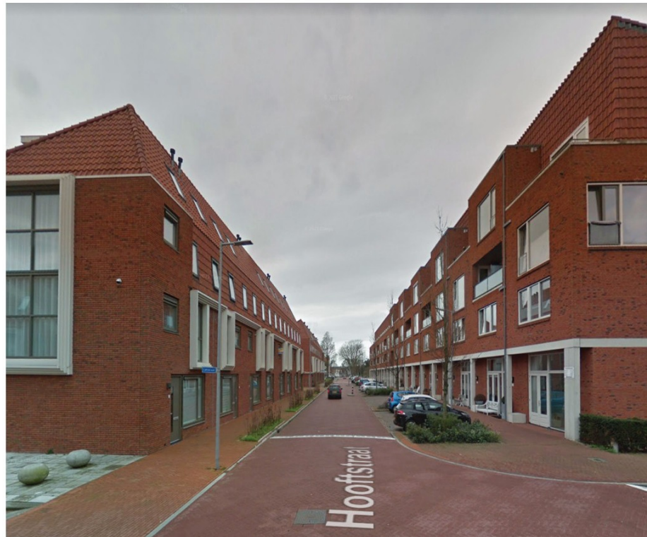
Wijkontsluiting de PC Hooftstraat, zicht richting Vondelstraat
