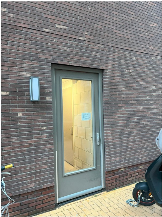
geen beschadigingen rondom ingangen en openbare hoeken
