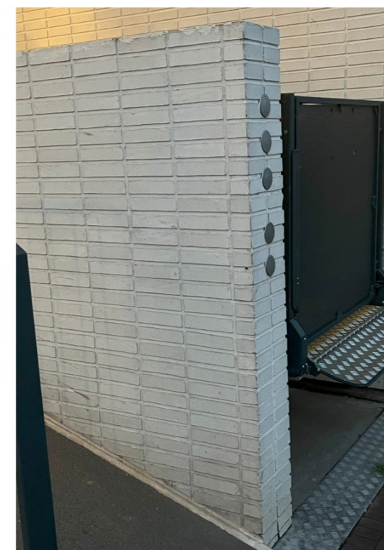
kwetsbare hoeken vermijden, net als bij metselwerk.
