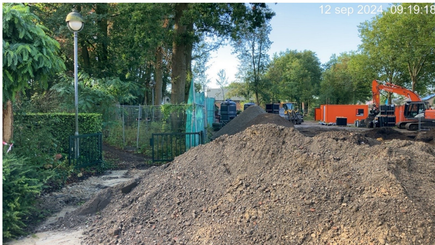
Locatie bouw hek, gezien vanaf de linkerkant
