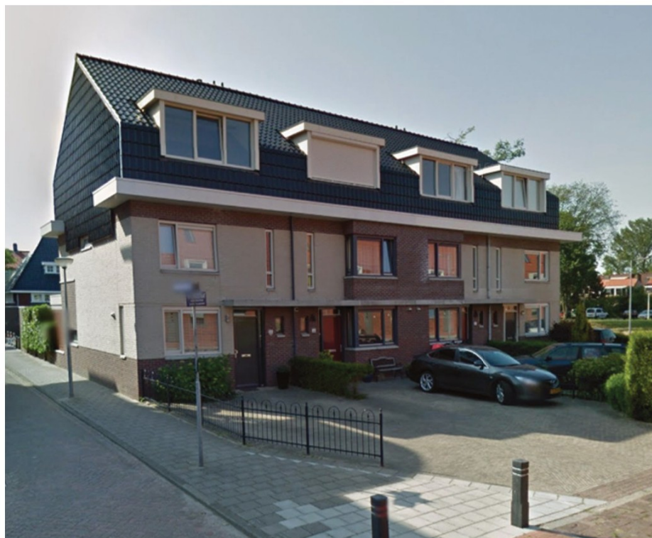
Rijwoning achter voormalig schoolgebouw, Brederostraat
