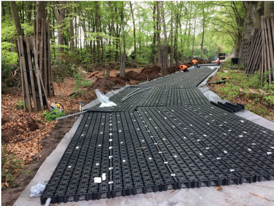
Afbeelding 16: Toepassing van PermaVoidkragen als fundering van een betonnen fietspad in een bos;
