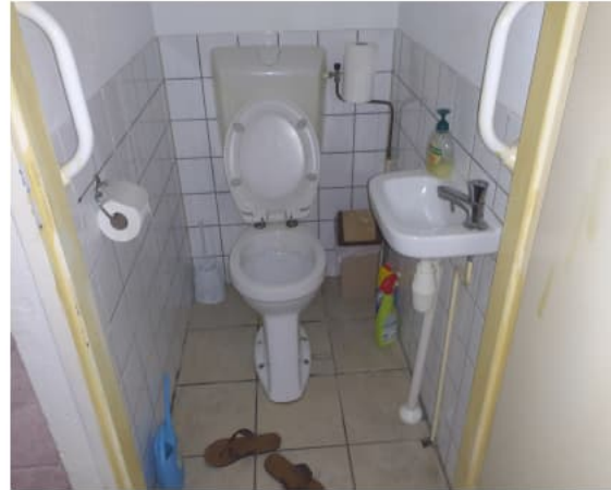
toilet, vloertegels in speci/cement gezet, zichtbare riolering PVC
