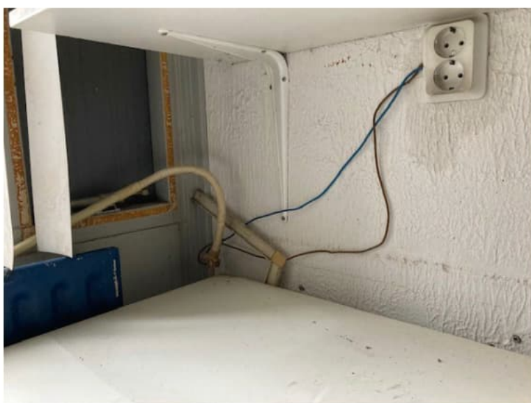
Wandcontactdoos met doorschakeling in studeerkamer
