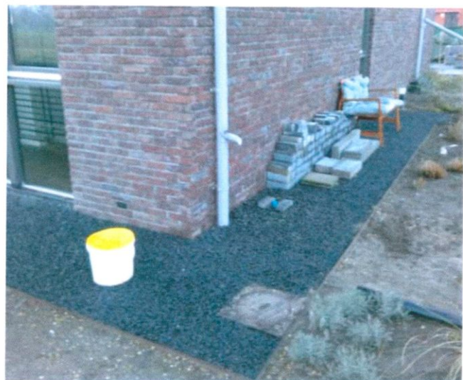
Foto 2 Locatie ondiep filterbuis
