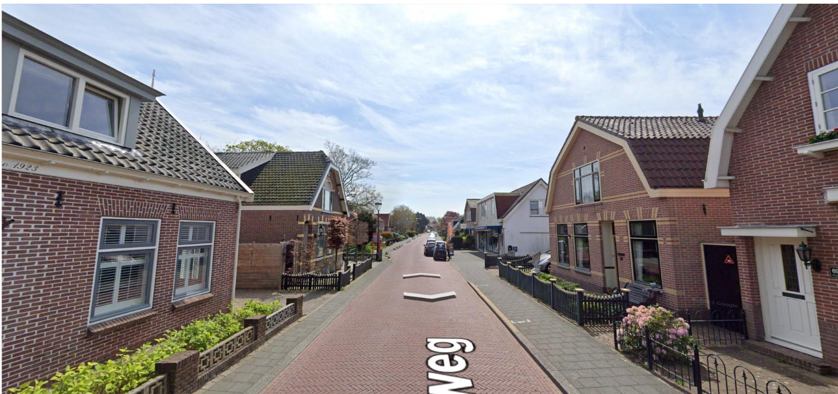
Het beoogde plangebied (rechts) en naastgelegen lintbebouwing met diverse kapvormen, waaronder het zadeldak.
