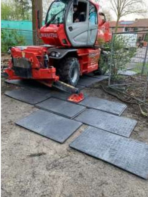
Machine op rijplaten gestempeld
