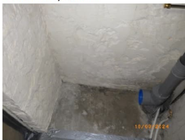
12. Locatie verwijderd asbest
