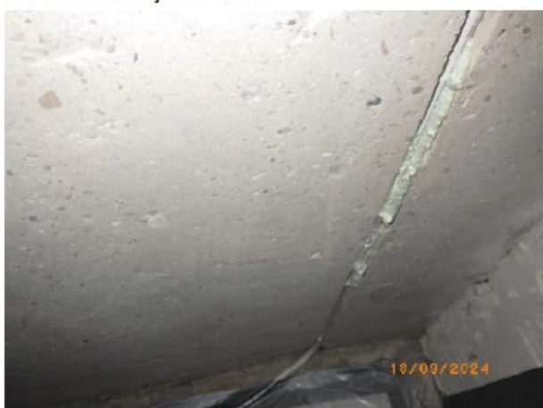
11. Locatie verwijderd asbest
