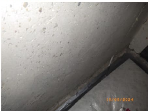
9. Locatie verwijderd asbest
