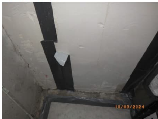
10. Locatie verwijderd asbest
